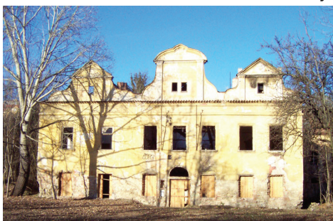
Usedlost Kajetánka před rekonstrukcí
