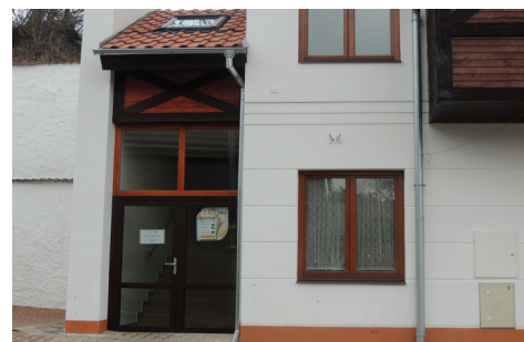
Detail renovovaného vstupu hasičárny
