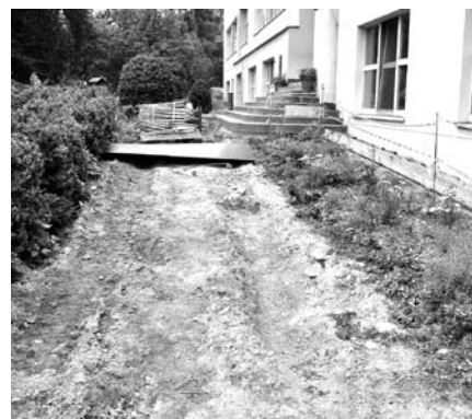
Rekonstrukce školy - venkovní práce
